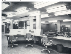
TX-0, MIT林肯实验室, 1956年, 它将键盘、打印机、磁带阅读机和打孔机集成在一起, 操作员可以通过键盘编程, 生成印好的磁带后直接输入机器: 配有一台可编程显示器。
